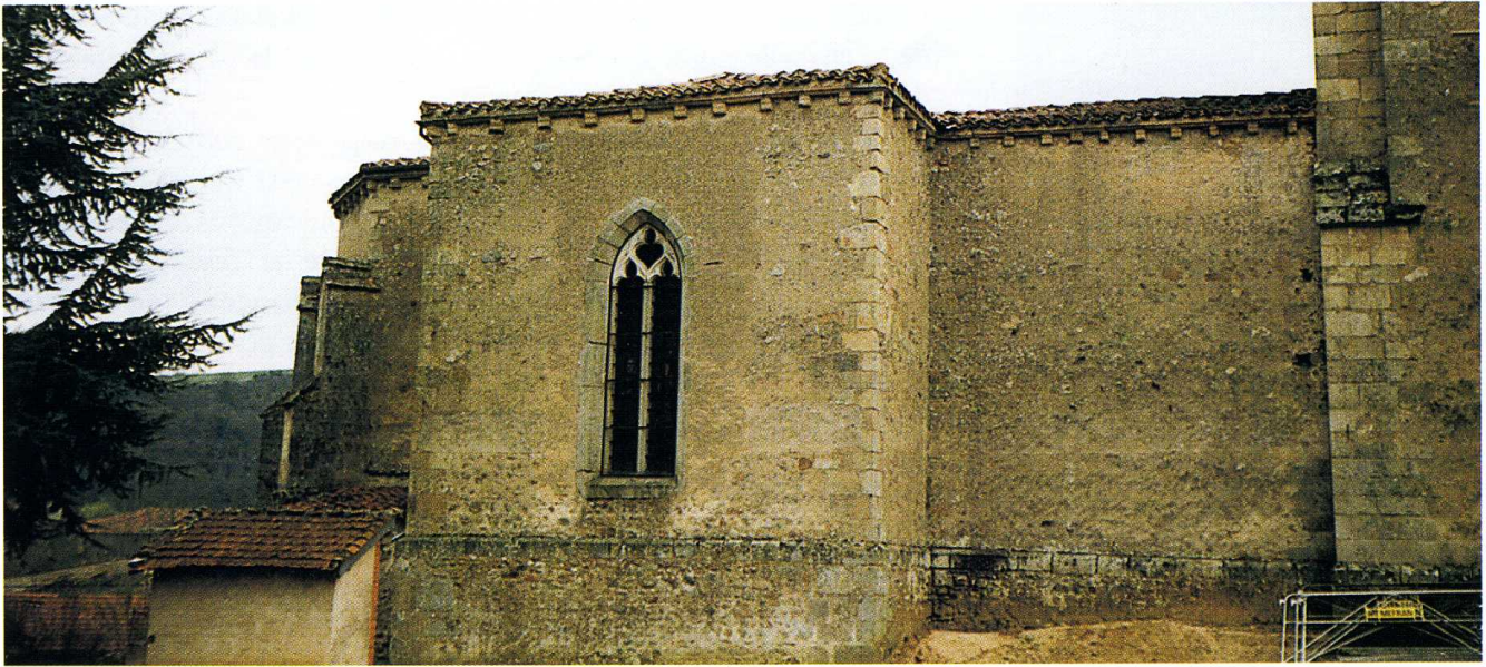
Saint-Laurent-Rochefort (Loire) Église Saint-Laurent Façade nord
