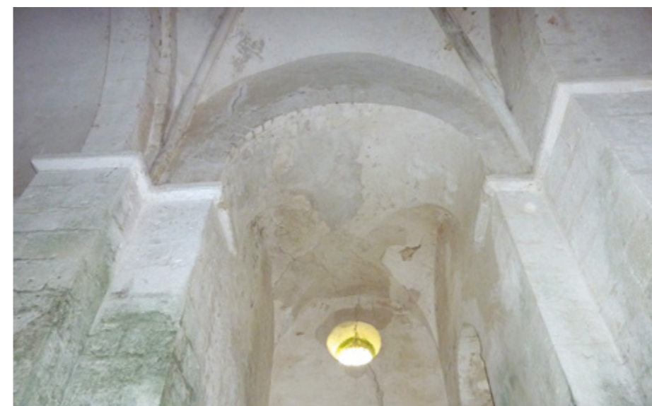
6. Voûtement d'un bras de transept
