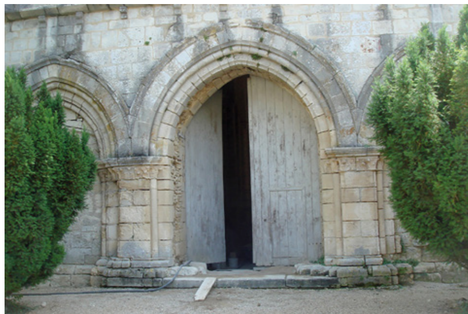
5. Portail avant restauration
