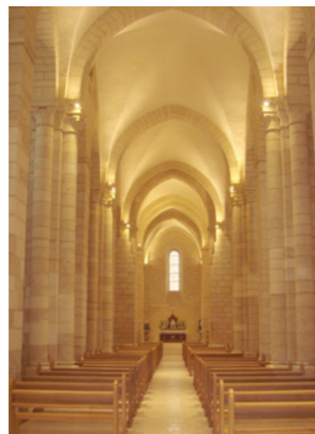
7. Vue intérieure vers le chœur après restauration
