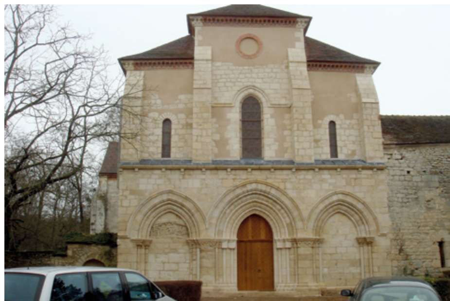
6. Façade ouest après restauration
