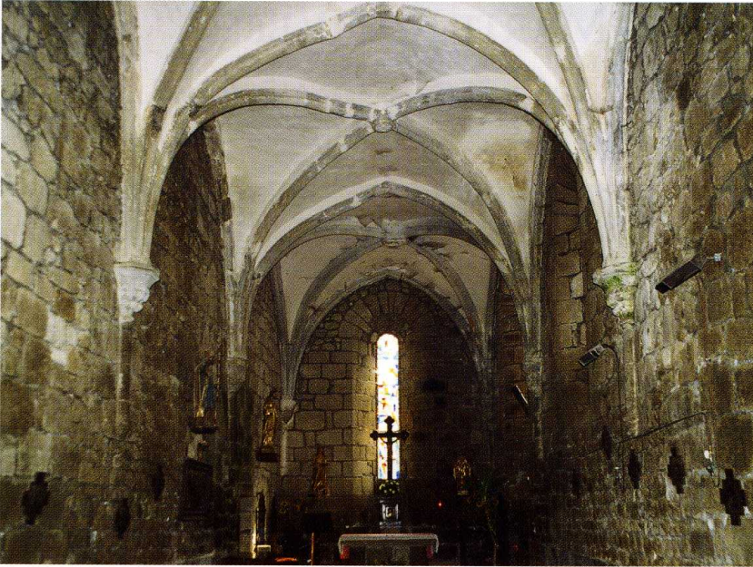
Saint-Martial-le-Mont (Creuse) Église Saint-Martial 3. Intérieur de l'église vers le chœur
