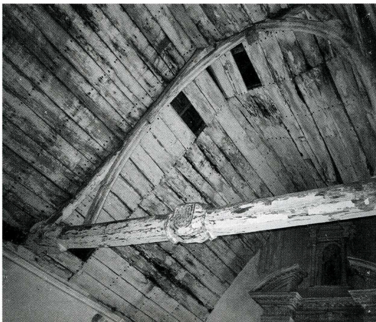
Saint-Martin-des-Prés (Côtes-d'Armor). Chapelle Saint-Roch, voûte lambrissée, avant travaux.
