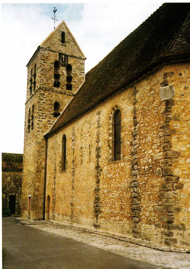
Saint-Martin-en-Bière (Seine-et-Marne) Église Saint-Martin Mur sud et clocher
