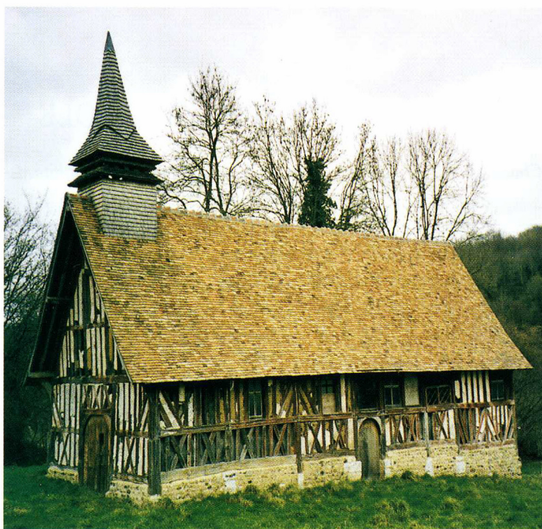
Saint-Martin-Saint-Firmin (Eure) Chapelle Saint-Firmin Vue du sud-ouest
