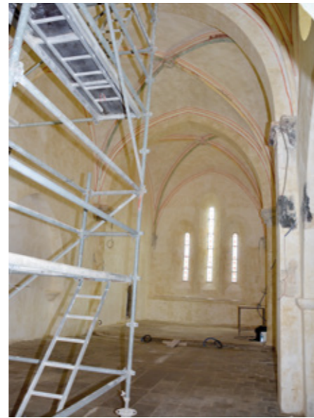
6. Vue intérieure vers le chœur en cours de restauration
