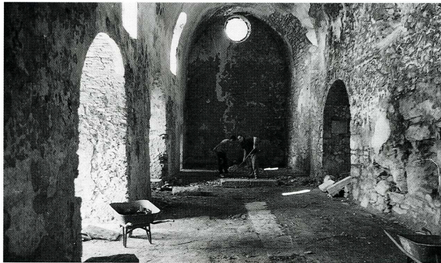
Saint-Michel (Hérault). Église Saint-Michel d'Alajou, intérieur de la nef en cours de travaux.
