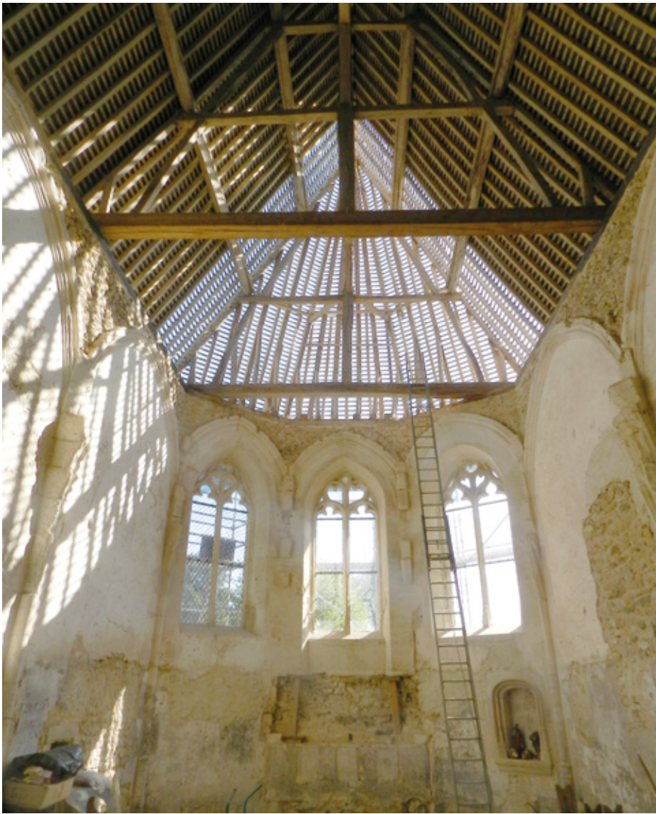
7. Charpente de l'abside pendant les travaux
