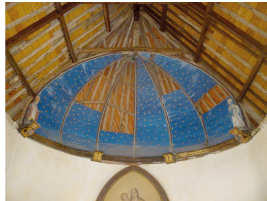
4. Voûte en cul-de-four du chœur
