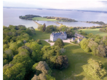
1. Vue du site
