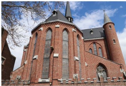
Église Saint-Joseph (Roubaix) (Nord). 1. Vue du chœur après les travaux de restauration. 2. Vue vers le chœur.
