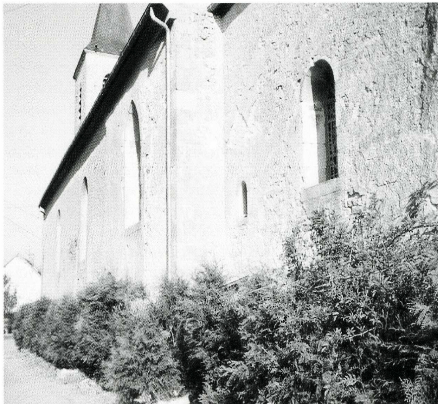
Saxi-Bourdon (Nièvre), église Saint-Léger, façade sud avant travaux.
