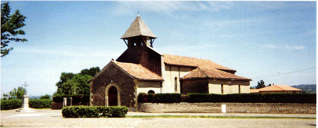
Ségos (Gers) Église Saint-Orens 1. L'église avant travaux 2. Élévation sud de l'édifice
