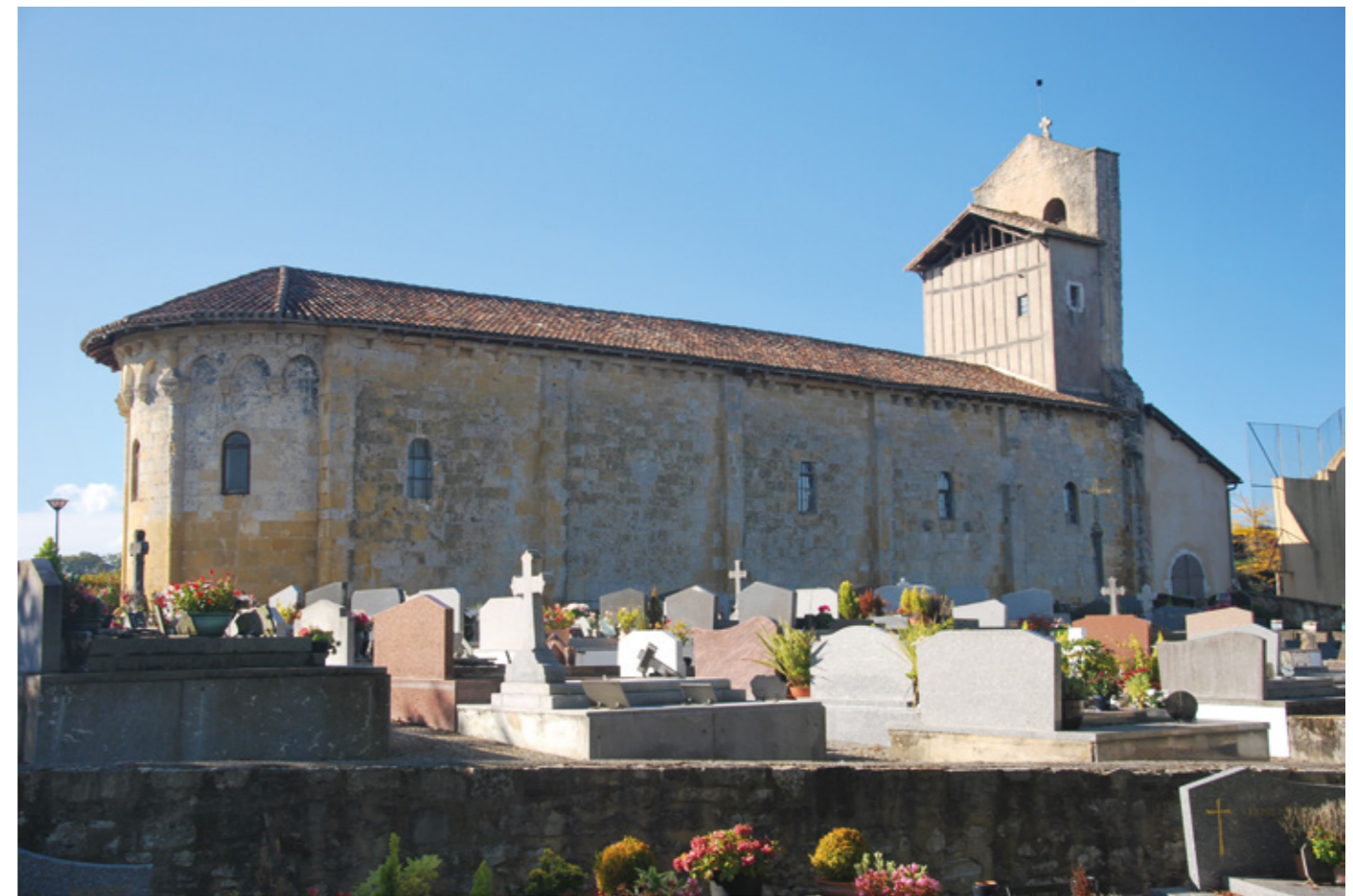
1. Vue générale de la façade nord
