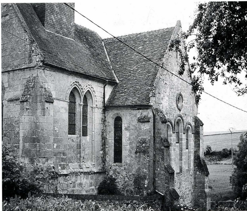
Sommelans (Aisne). Église Saint-Éloi, façades sud de la nef et du transept.
