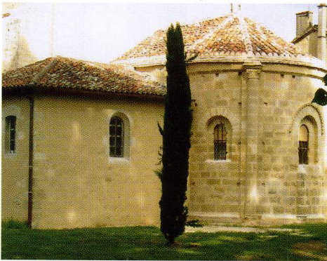
Sommières-du-Clain (Vienne) Église Saint-Gaudent 2. Vue générale après travaux 3. Chevet après travaux
