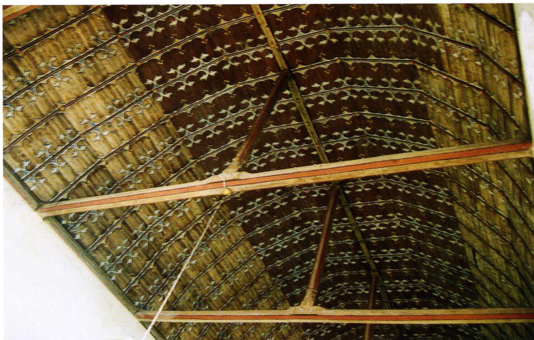
Souancé-au-Perche (Eure-et-Loir) Église Saint-Georges Voûte lambrissée de la nef (cl. Arch. et Patr., 2001)
