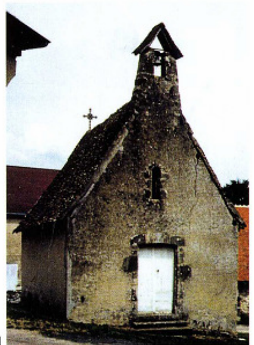
Sougy-sur-Loire (Nièvre) Chapelle Sainte-Catherine de Tinte 1. Façade ouest 2. Charpente privée de son lambris
