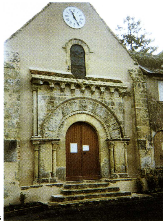
Souvigny-de-Touraine (Indre-et-Loire) Église Saint-Saturnin 3. Façade occidentale 4. Vue intérieure
