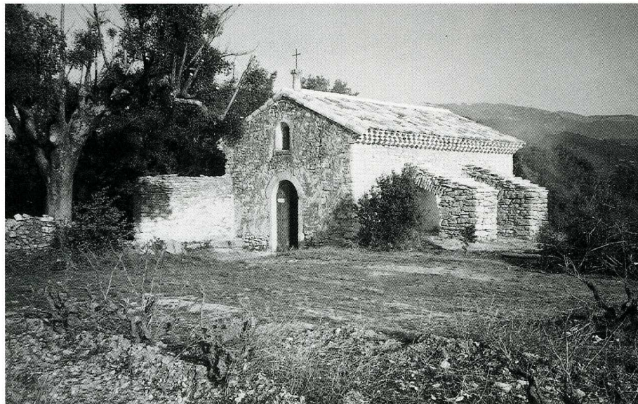
Taulignan (Drôme). Chapelle Saint-Marcel, vue du sud-ouest après restauration.
