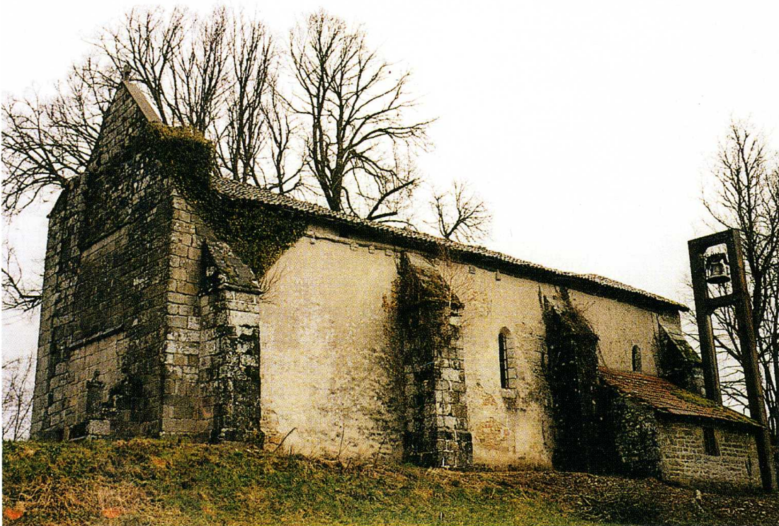
Thauron (Creuse) Église Saint-Christophe Vue d'ensemble
