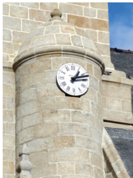
4. Tourelle d'escalier sur la façade sud du clocher
