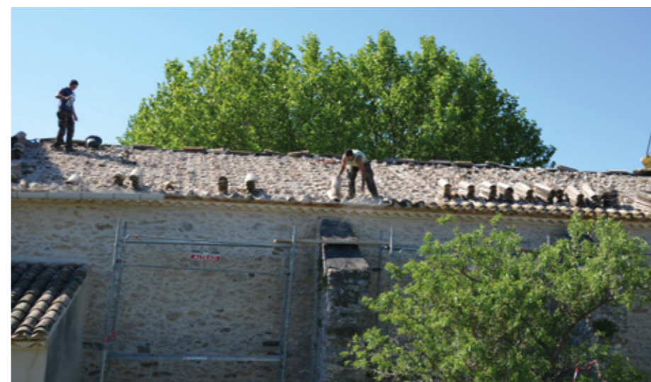
3. Toiture en cours de restauration
