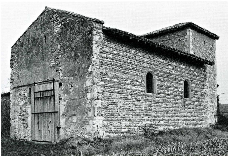
Valeins (Ain). Église Saint-Laurent. Vue générale de l'édifice de l'angle sud-ouest.
