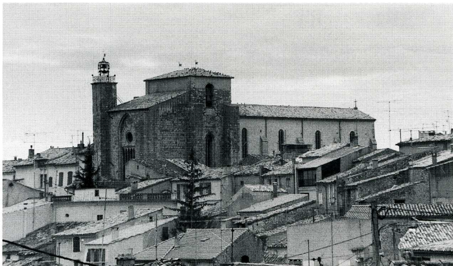
Valensole (Alpes-de-Haute-Provence). Église Saint-Blaise, vue d'ensemble.
