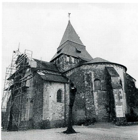
Vaulandry (Maine-et-Loire), église Saint-Pierre. Abside vue du sud-est.
