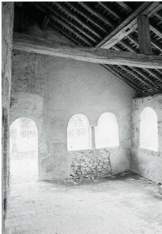
Verrières (Aube), chapelle Saint-Aventin, avant-porche.
