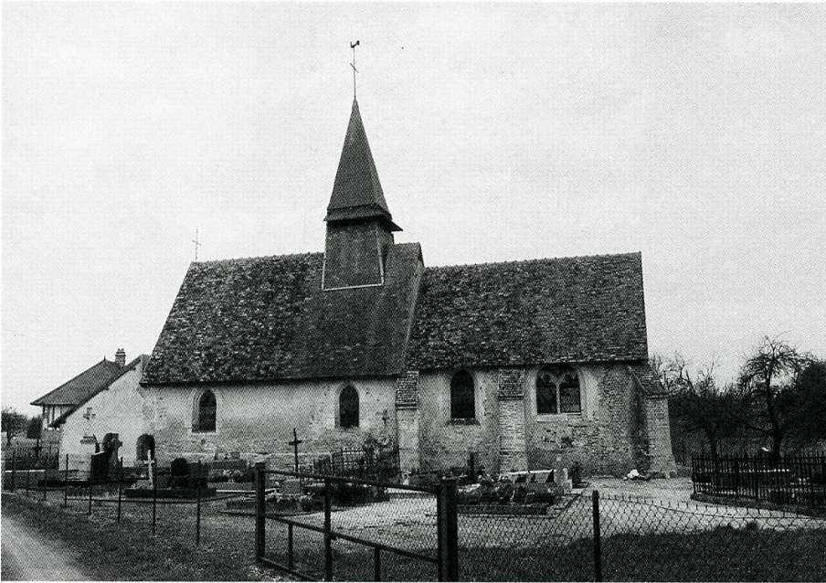
Verrières (Aube), chapelle Saint-Aventin, façade sud.
