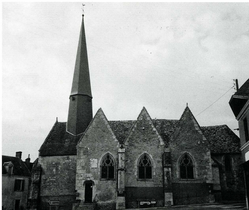
Verrières (Orne). Église Saint-Ouen, façade sud.
