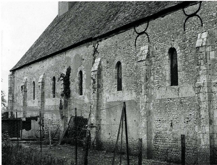
Vievy-le-Rayé (Loir-et-Cher). Église Saint-Pierre, élévation sud de la nef avant restauration.
