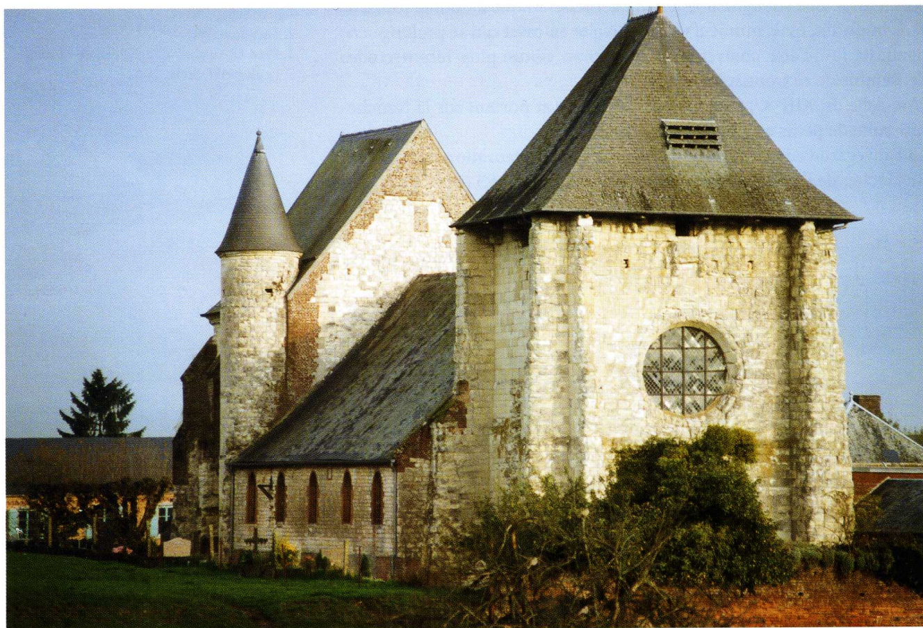
Vigneux-Hocquet (Aisne) Église Saint-Martin 1. Façade nord (cl. Assoc.)
