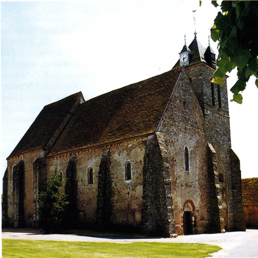
Villethierry (Yonne) Église Saint-Loup Façade nord et façade occidentale
