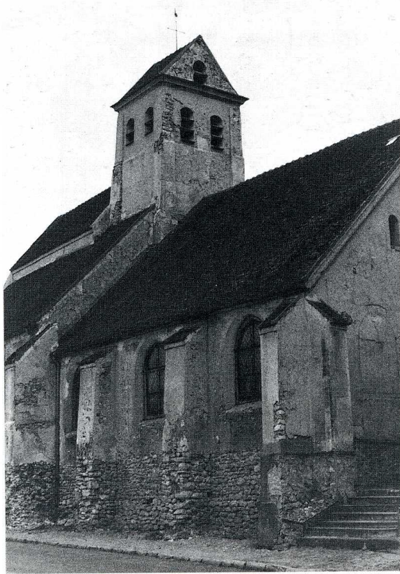
Vinantes (Seine-et-Marne). Église Notre-Dame de la Nativité, bas-côté nord de la nef et clocher.
