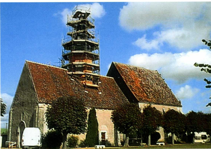
Vitray-en-Beauce (Eure-et-Loir) Église Saint-Denis Façade sud pendant les travaux
