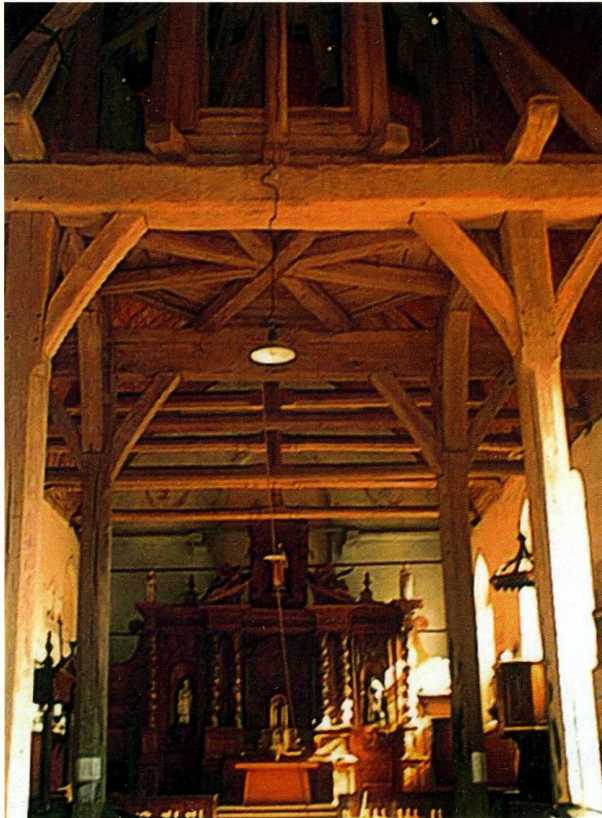
Vitray-en-Beauce (Eure-et-Loir) Église Saint-Denis Vue intérieure vers l'abside
