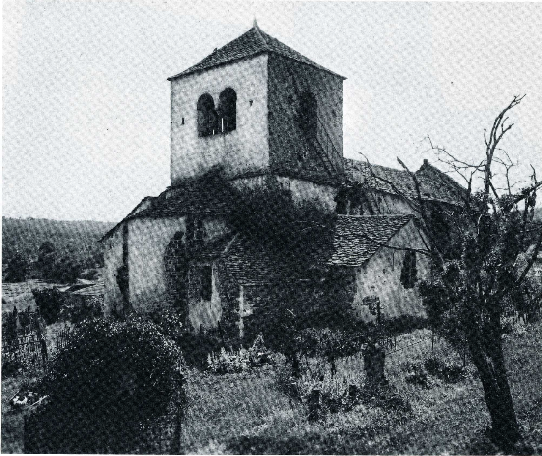
Vodable (Puy-de-Dôme). Église de Colamine.
